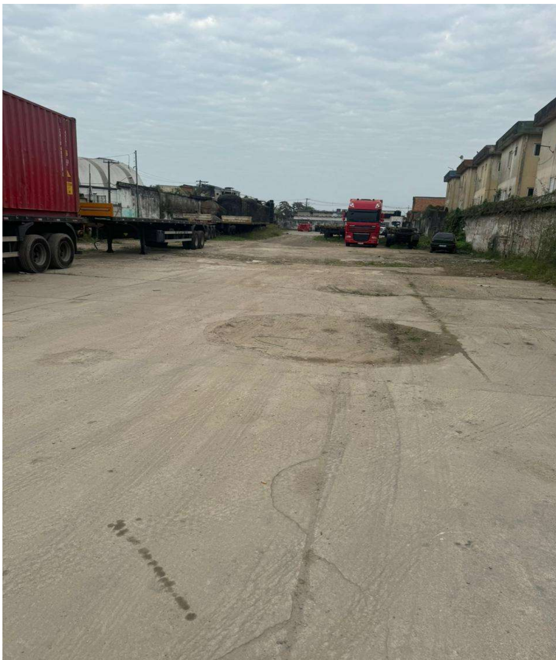
TERRENO APÓS RETIRADA DE TANQUES, ESTRUTURAS COLAPSADAS E LIMPEZA
